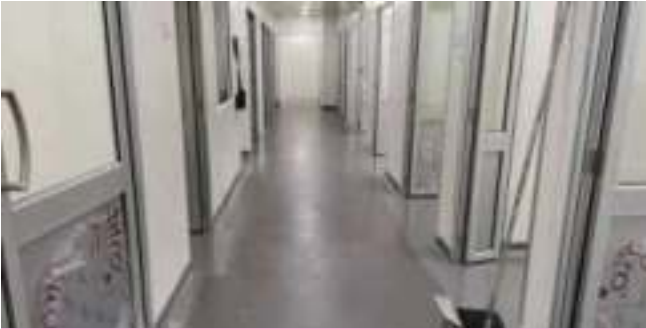
Epoxy Primer + PU MS Topcoat 3mm for Food Industry
