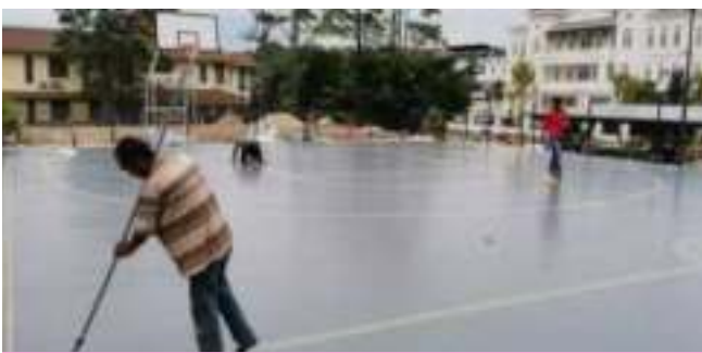
Epoxy Primer + PU Topcoat + Line for Basket Ball Court
