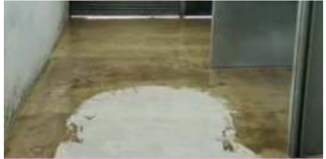
Epoxy Filler + Primer for Broken Floor
